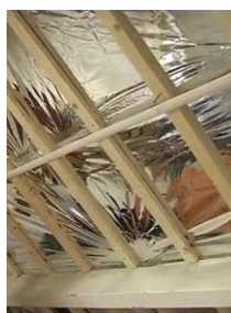
Isoleren met reflecterende folies
