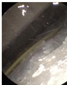
Spouwfoto met een endoscoop
