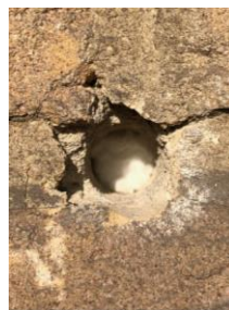
Boorgat met spouwisolatie
