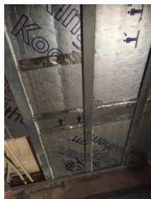
Voorzetwand met PIR-isolatie
