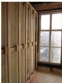
Voorzetwand met houten regels
