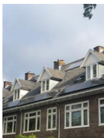
PV-panelen op hellende daken
