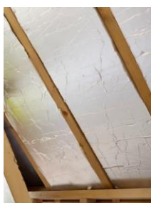
Isoleren met PIR-platen
