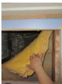
Isolatie met glaswol
