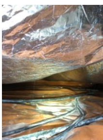
Isolatie met Tonzon isolatie
