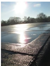
Isolatie onder dakbedekking
