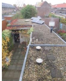
Vergeet niet de daken van aanbouwen
